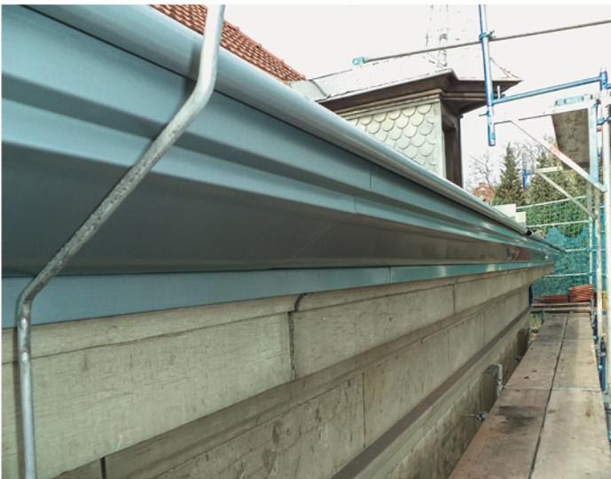
Die Gesimsrinne aus Titanzink mit ihrem ausdrucksstarken Wulst schließt unmittelbar an den Sandstein an und ist dadurch in der Ansicht von unten kaum als eigenständiges Bauteil wahrnehmbar
