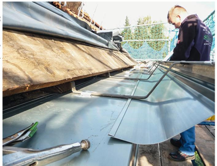
Detail der Dachentwässerung mit Trägerprofilblech, den aufgearbeiteten Rinnenhaltern sowie dem nach alten Zeichnungen erneuerten Karniesblech
